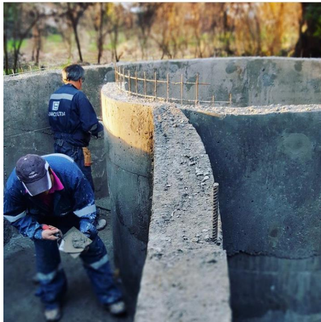
Figura 22 Construcción del caracol Fuente: Turbulent (2018)
