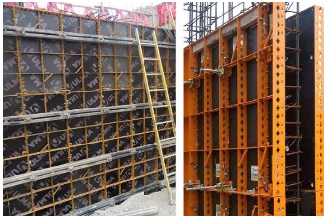
Figura 28 Molde de encofrado para el hormigón Fuente: ulmaconstruction.cl
