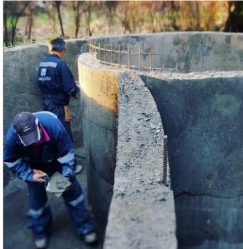
Figura 29 Revestimiento estructura de caracol Fuente: Turbulent (2018)
