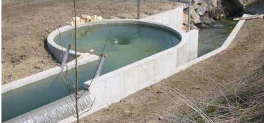
Figura 26 Obra civil de rebalse Fuente: Zotloterer (2004)
