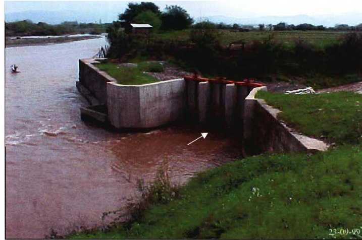
Figura 23 Bocatoma El Huicano Fuente: DGA (1999)
