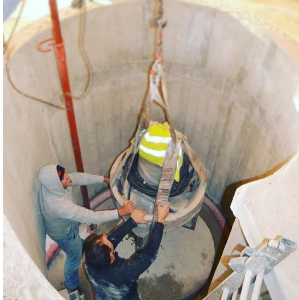
Figura 30 Instalación de la TVG Fuente: Turbulent (2018)
