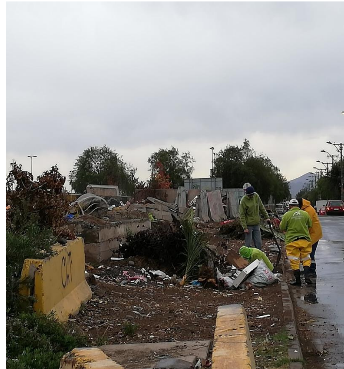
b. Personal municipal realizando obras para evacuación de agua
