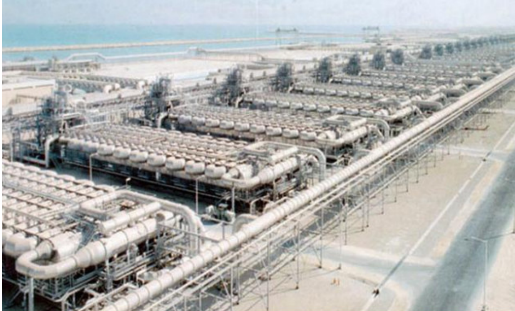
Figura 57: Planta de desalación MSF Al-Jubail (Arabia Saudí)
