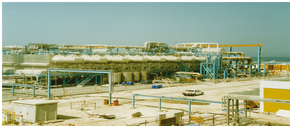
Figura 60: Planta de desalinización MSF en Jebel Ali G estación, Dubai
