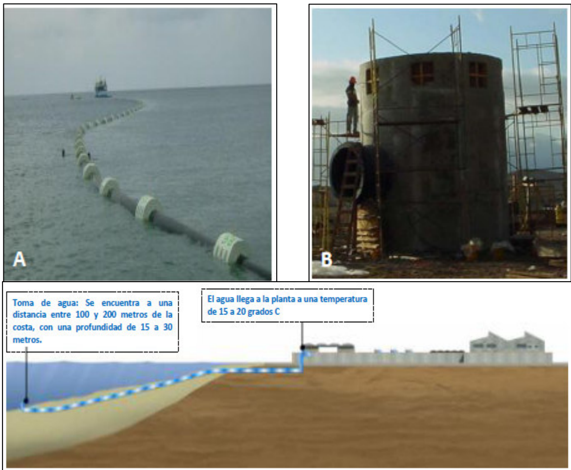
Figura 45: Captación de agua de mar
