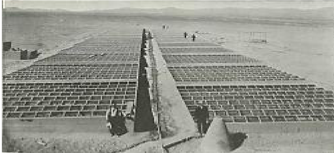
Figura 22: Primera planta solar desalinizadora de agua en el mundo. Desierto de Atacama
