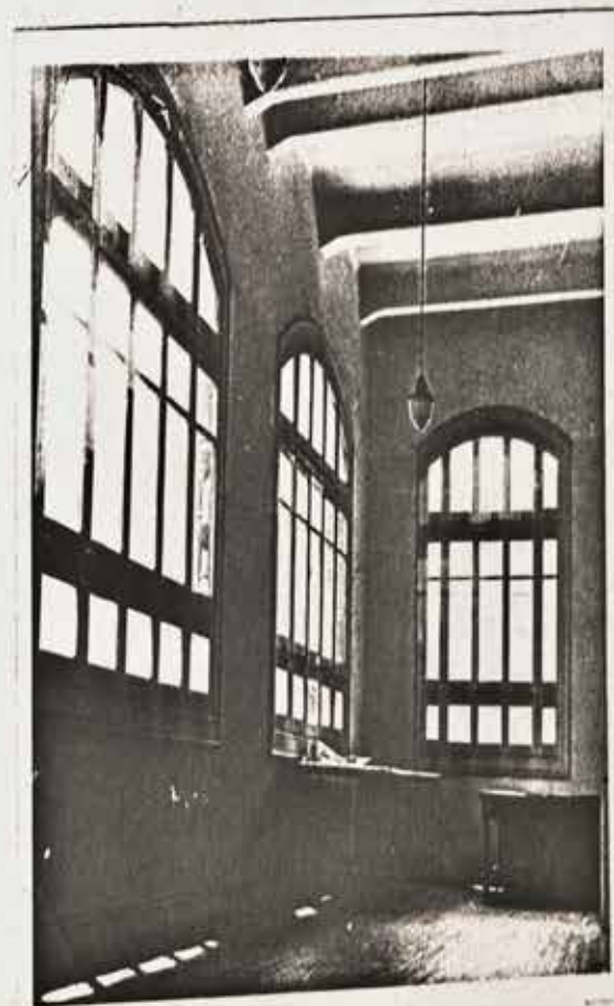
Espacio destinado a nueva Biblioteca (muros)
