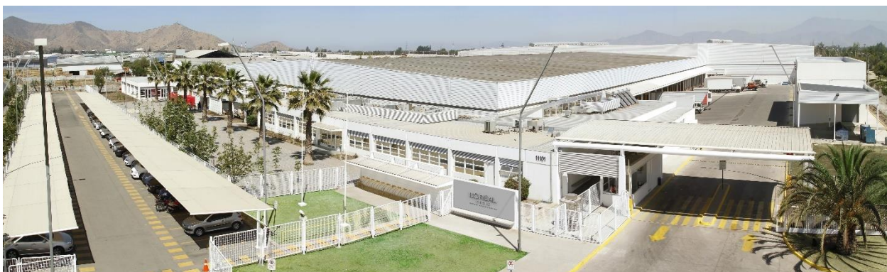
Ilustración 3.1.3 Imagen exterior de CENTREX
