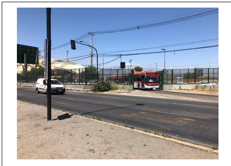
Figura N° 5.12: Salida Intermodal del Sol, Maipú
