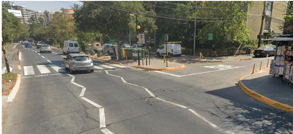
IMAGEN 1: INTERSECCIÓN AV. ANTONIO VARAS CON DR. SOLÍS DE OVANDO. FUENTE: GOOGLE EARTH.
