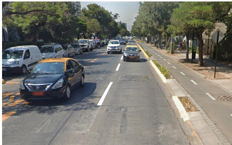
IMAGEN 9: REDUCTORES DE VELOCIDAD CERCANOS A LA INTERSECCIÓN. FUENTE: GOOGLE EARTH.
