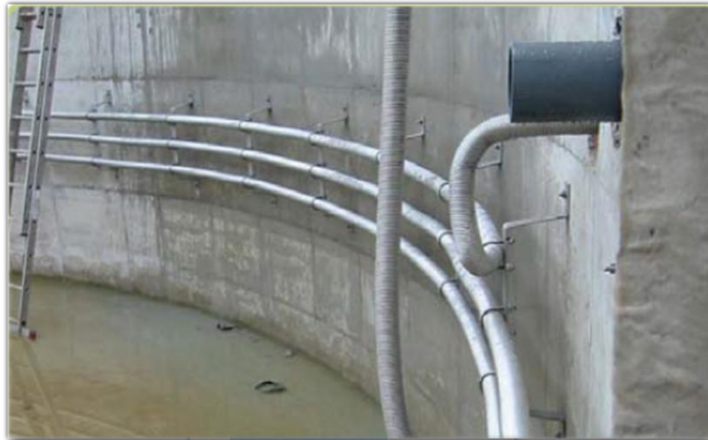
Ilustración 4-16 Sistema de calefacción del biorreactor por cogeneración
