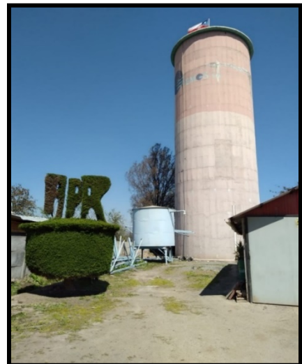
Figura 23: Infraestructura del Servicio Sanitario Rural “Lonquén Sorrento”.
