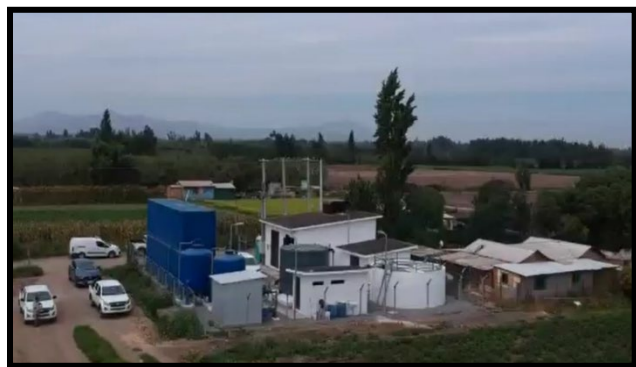
Figura 24: Infraestructura del Servicio Sanitario Rural “La Esperanza – Santa Mónica”.
